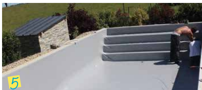
Colocación del fieltro y el revestimiento.
