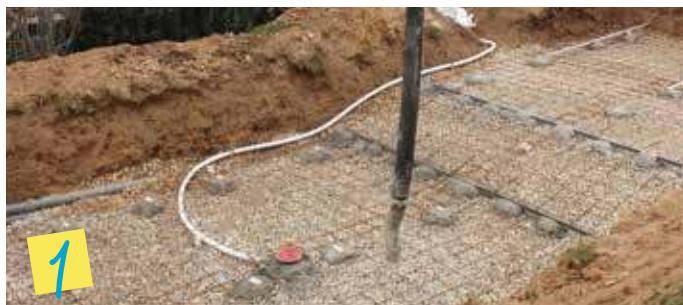
Movimiento de tierras, armaduras y hormigón de fondo.
