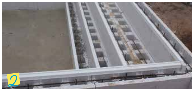
Montaje de los bloques y estructura.
