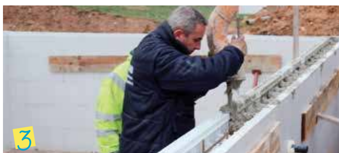
Vertido del hormigón.
