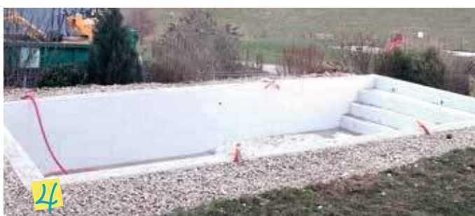
Relleno, alisado, colocación del carril y colocación del borde.
